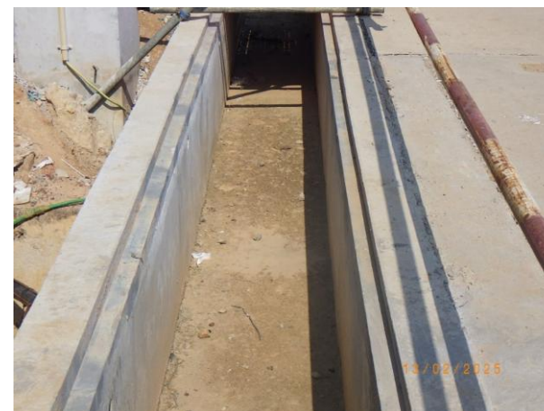
รูปที่ 2-11 บ่อพักรวบรวมตะกอนคอนกรีต
