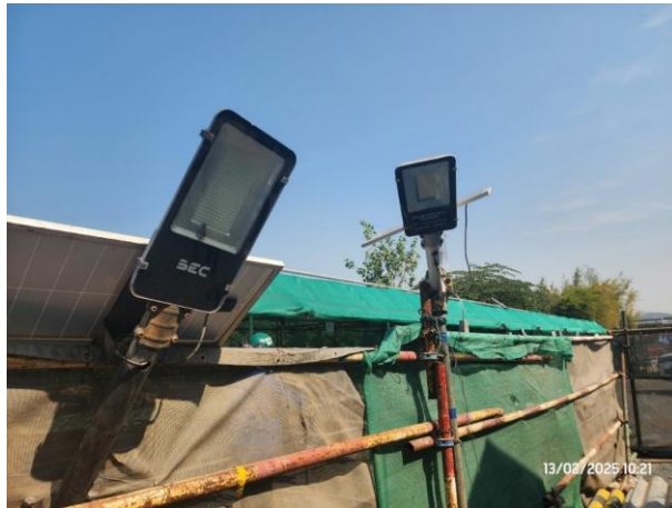
รูปที่ 2-35 ไฟฟ้าส่องสว่างฉุกเฉิน
