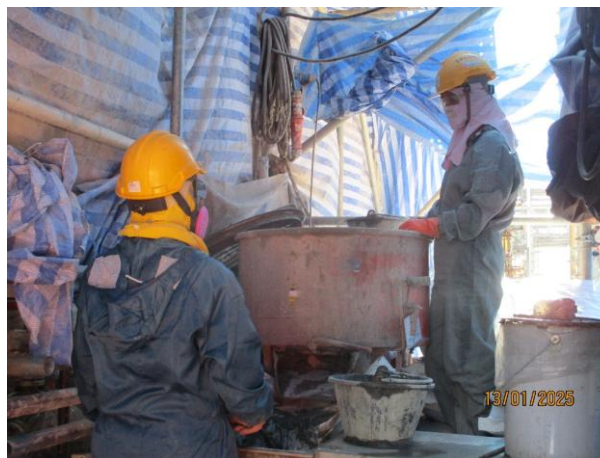
รูปที่ 2-32 (ต่อ) การสวมใส่อุปกรณ์คุ้มครองความปลอดภัยส่วนบุคคลตามลักษณะงาน
