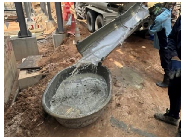
รูปที่ 2-11 บ่อพักรวบรวมตะกอนคอนกรีต
