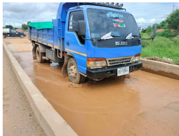
รูปที่ 2-6 ที่ล้างล้อรถบรรทุก
